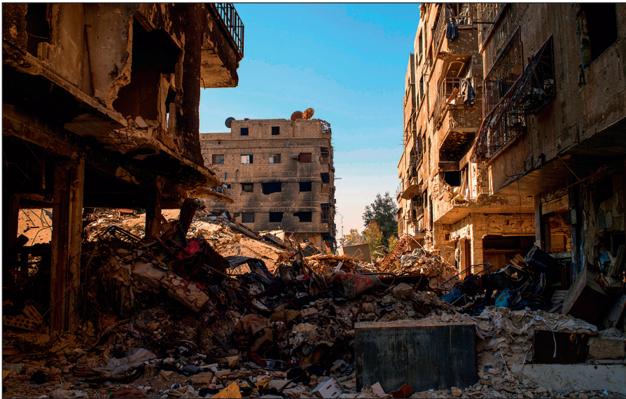
Разрушенный боевиками ИГИЛ Дамаск.
